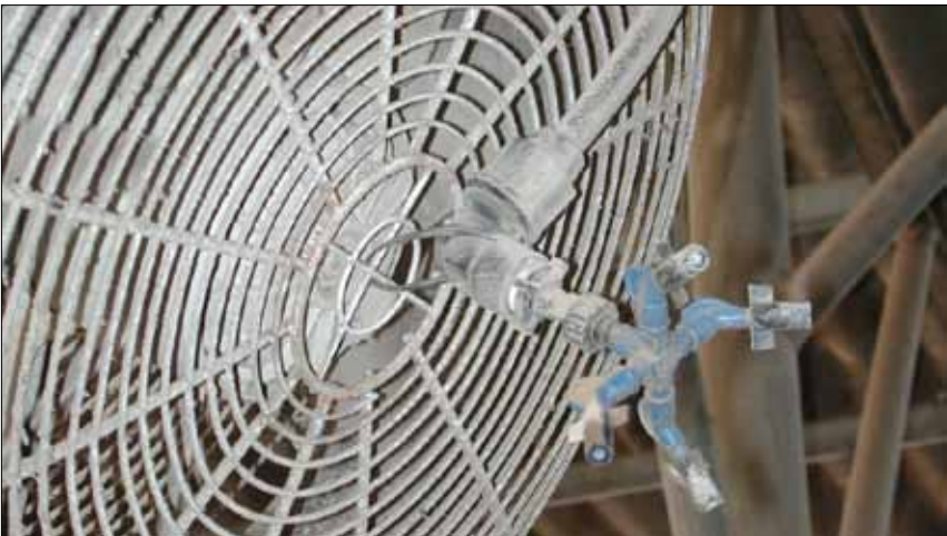
Bild 7. Vattenmunstycket avger små vattendroppar som blåses ut över korna (Foto: Delaval AB).
