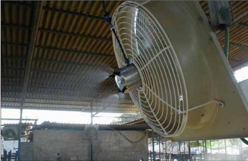
Bild 6. Ett vattenmunstycke framför en fläkt åstadkommer en nerky- lande dimma i stallet (Foto: Delaval AB).
