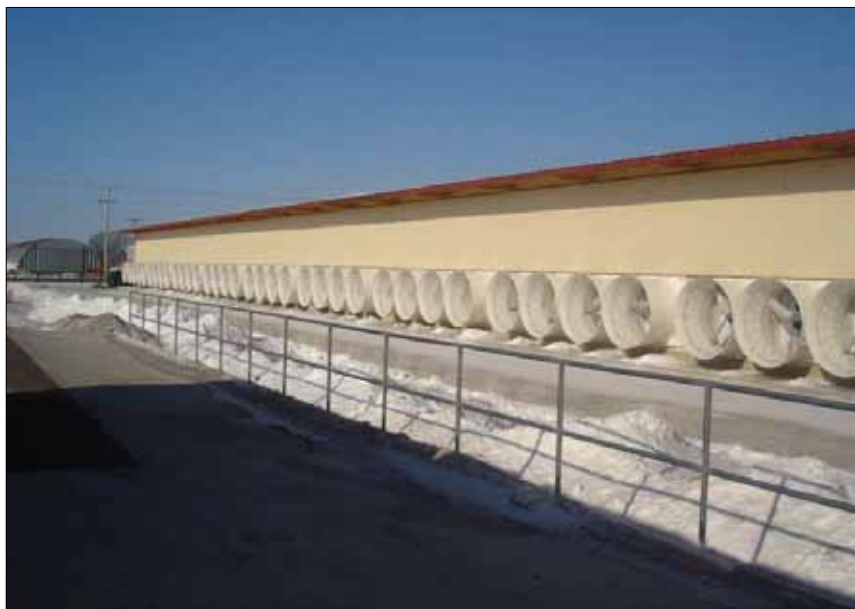
Bild 4. Cross ventilation liknar tunnelventilation men luften dras från ena långsidan till den andra (Foto: Delaval AB).
