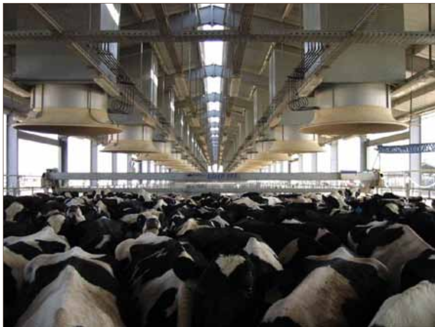
Bild 2. Luften trycks ned över korna. Vid varje fläkt sitter ett vattenmunstycke som bildar en avkylande dimma. Dessa kan placeras över samlingsfållan och är ganska vanlig i de delar av världen med torrt och varmt klimat (Foto:Delaval AB).
